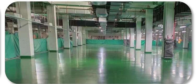
2樓圖形電鍍地坪施工
