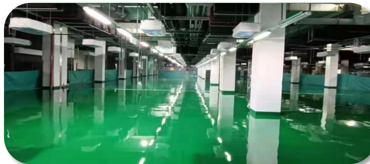
2樓水平電鍍地坪施工
