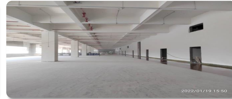
FAB1 2樓消防施工
