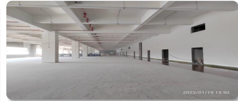
FAB1 2樓消防施工
