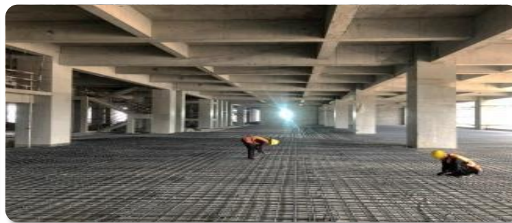
FAB1 1樓地坪施工
