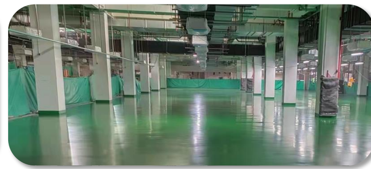
2樓圖形電鍍地坪施工
