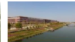
淮安第二園區 (FPC與先進模組 /HDI/Mini LED 背光 超薄細線路電路板)
