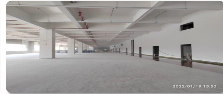
FAB1 2樓消防施工
