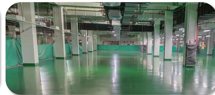
2樓圖形電鍍地坪施工
