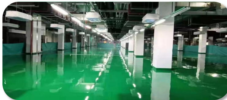
2樓水平電鍍地坪施工
