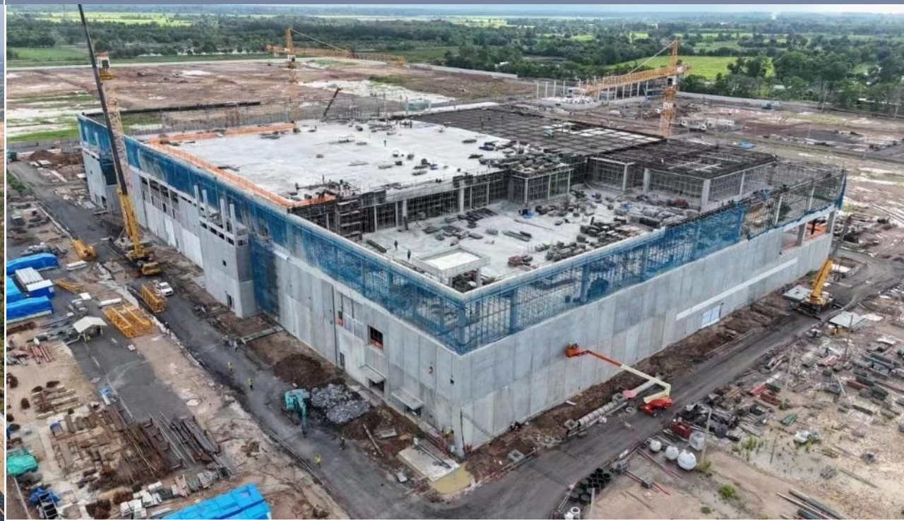
(現況)泰國巴真府園區第一期：高階 RPCB/HDI
