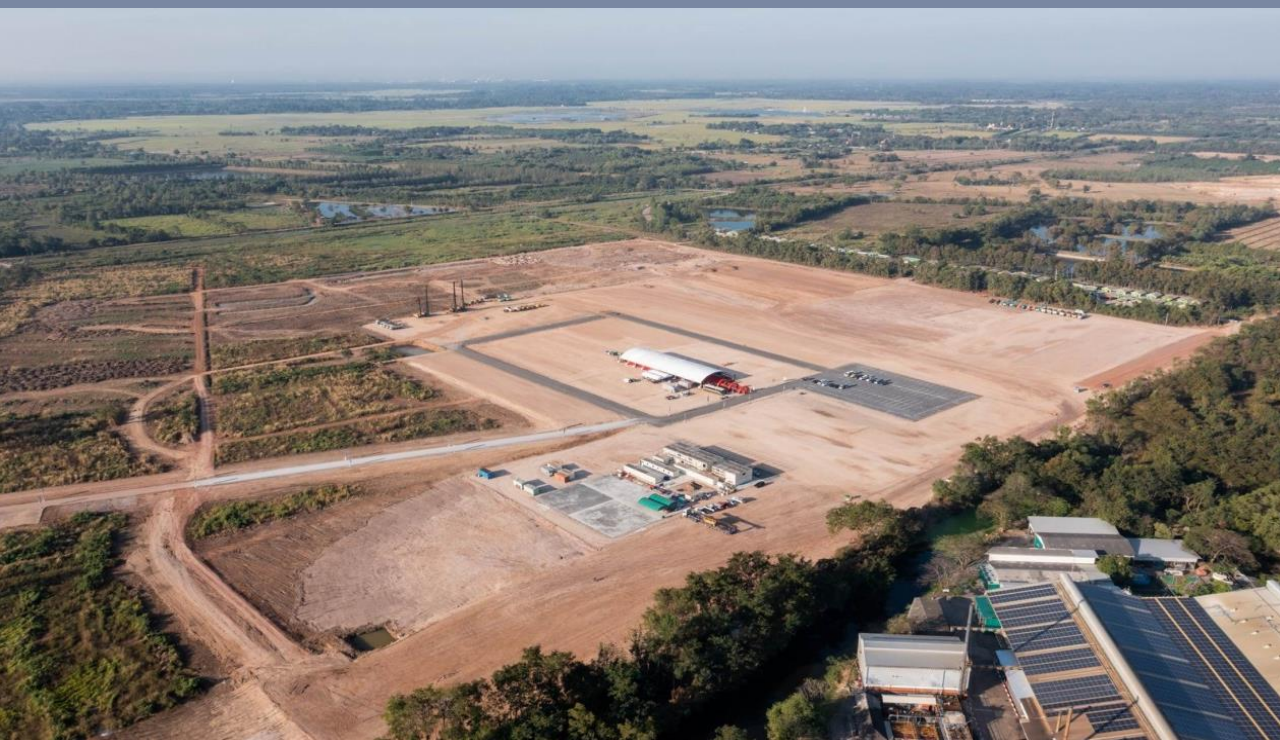
(去年12月)泰國巴真府園區第一期：高階 RPCB/HDI
