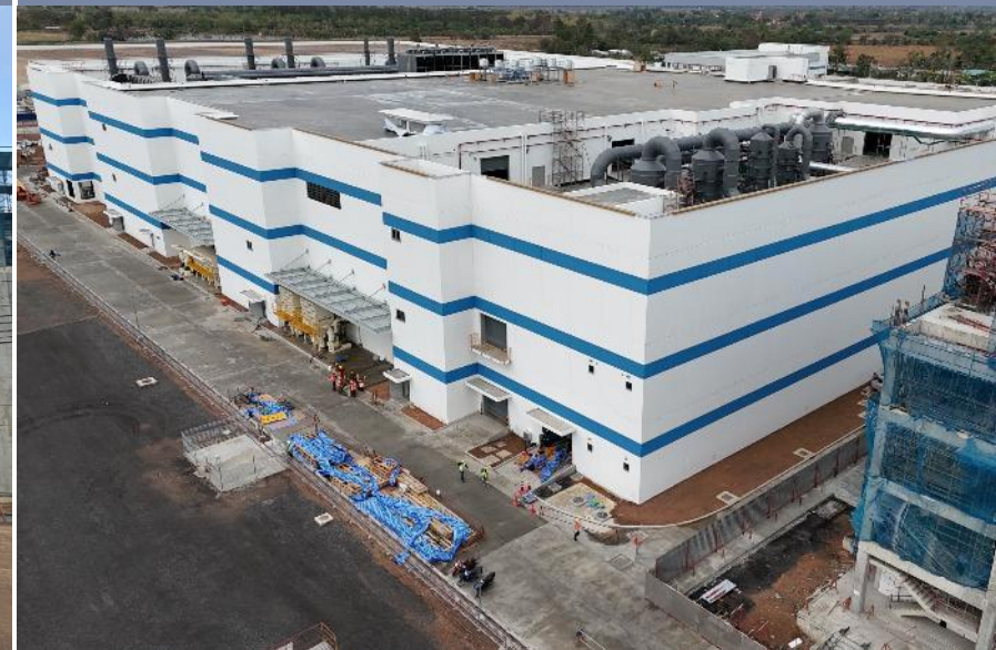
(2025年2月) 泰國園區現況
